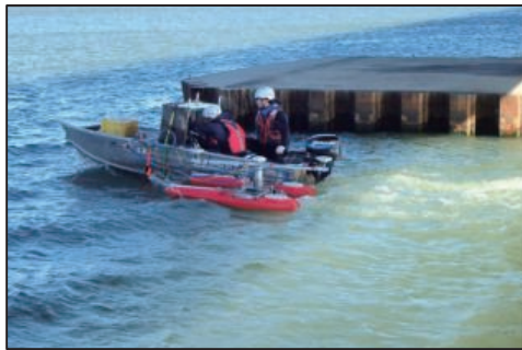
河床洗掘調査(矢板周辺)
